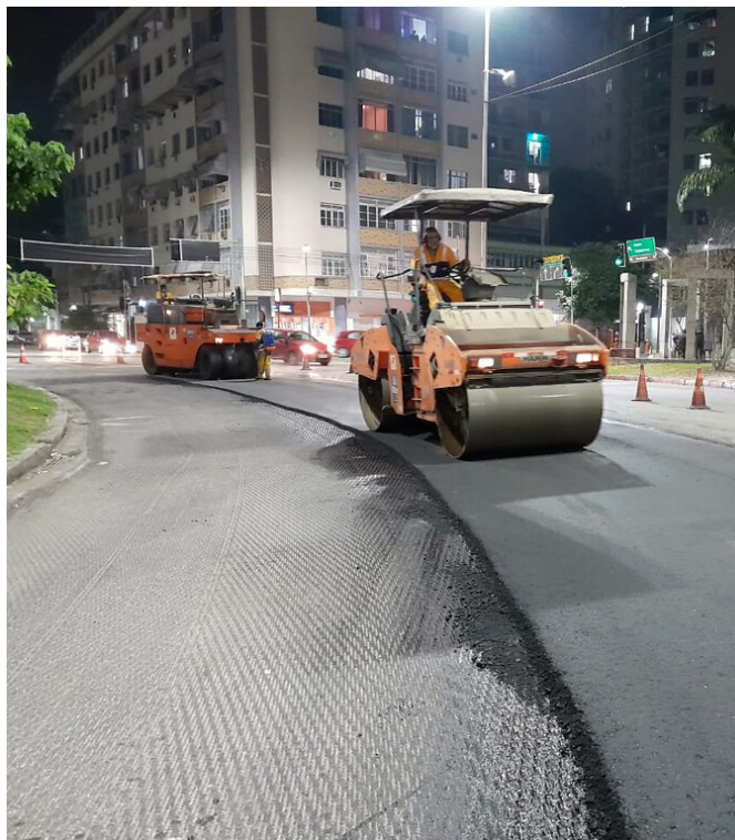
Figura 23. Substituição do pavimento no Boulevard 28 de Setembro
