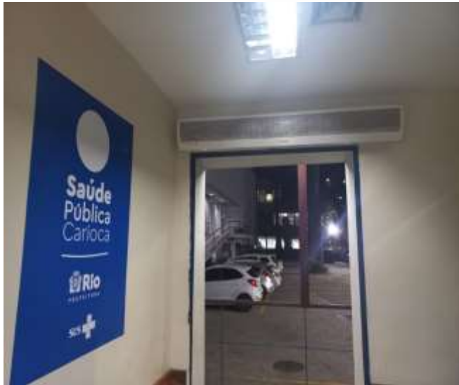
Entrada da Emergência Acesso a Recepção climatizada, cortina de ar e ventilador.
