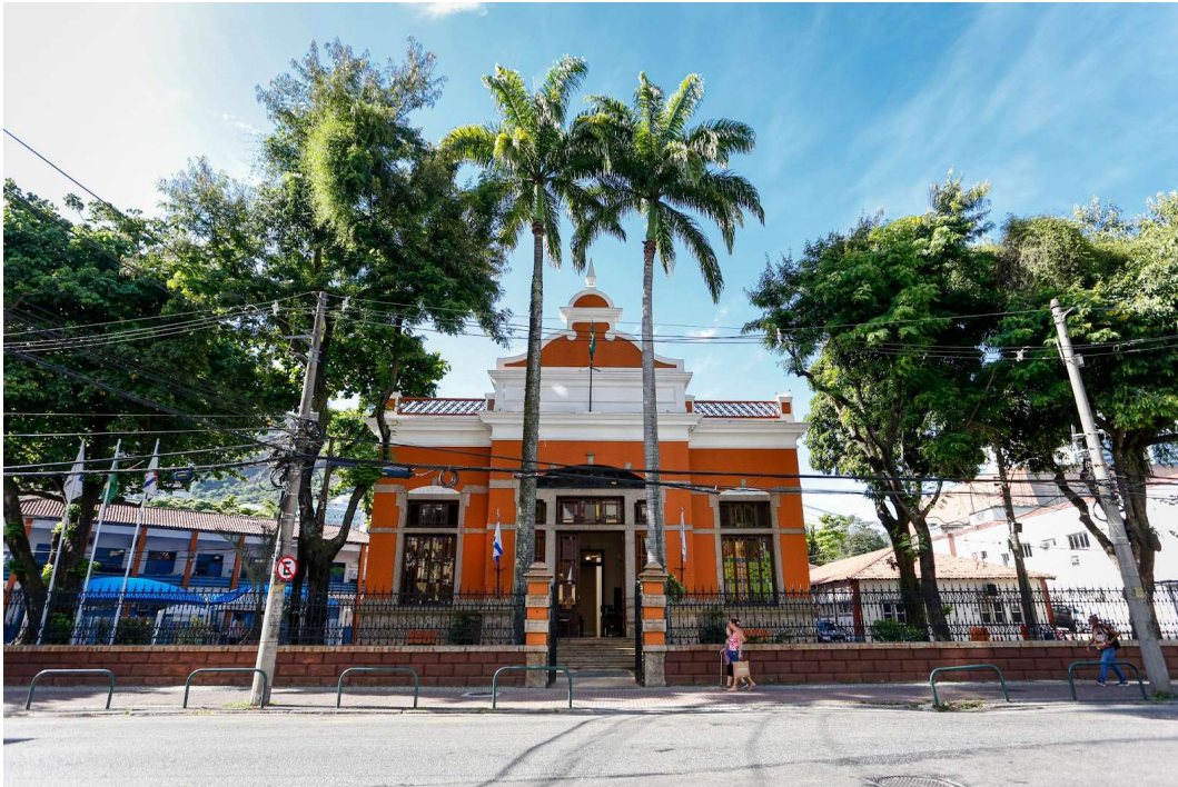
Fachada do novo Super Centro Carioca de Vacinação (no Hospital Municipal Rocha Maia) após reforma, em janeiro de 2023 Edu Kapps / Prefeitura do Rio
